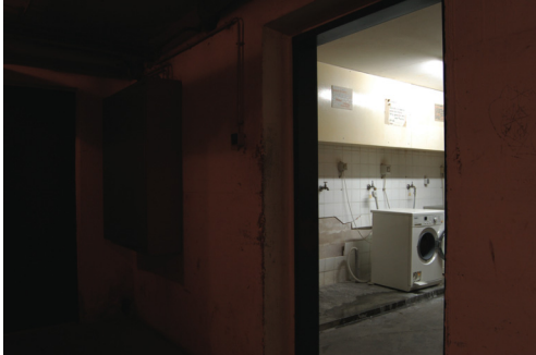
Abb.12_typischer „baulicher Angstraum“: es besteht kein Sicht- und Rufkontakt nach außen. Die ausschließlich künstliche Beleuchtung sorgt bei Stromausfall und Nachlassen der Leuchtqualität für dunkle Ecken. Waschküchen wurden oft im Keller angeordnet
