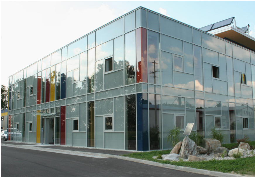
Abb.20_Produktionshalle und Bürogebäude Fa. Gasokol, Sachsen. Arch. Elisabeth Farkashazy
