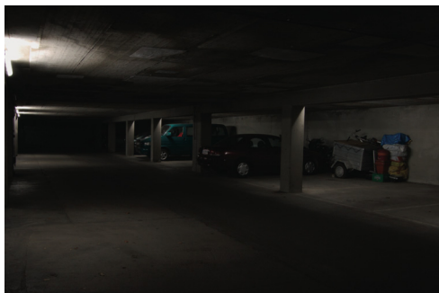
Abb.9__Die Tiefgarage als typischer baulicher Angstraum: es besteht kein Sicht- Rufkontakt nach außen, die Qualität und Anordnung der künstlichen Beleuchtung erzeugt dunkle Ecken.
