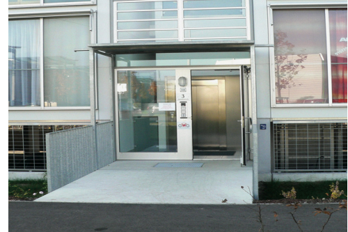
Abb.8_ heller Eingang, einsehbar verglastes Stiegenhaus, auch erkennbar die Tiefgarage mit vergitterten Öffnungen, die den Ruf- und Sichtkontakt ermöglichen
