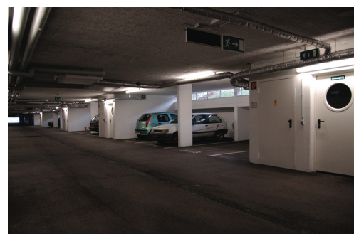
Abb.10__Garagenanlage und Autoabstellplätze sind barrierefrei erreichbar. Die Zugänglichkeit ist ausschließlich den BenutzerInnen möglich. Verbindung zu den einzelnen Stiegenhäusern und Anschluss an Liftanlagen. Es besteht direkter Sicht- und Rufkontakt nach außen. Eine natürliche Belichtung sorgt tagsüber für Helligkeit.
